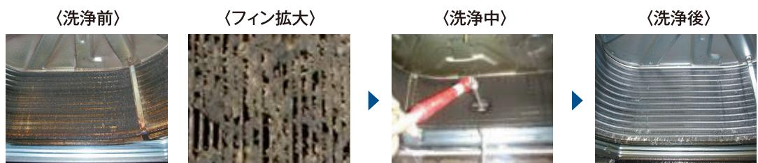
**状況** ホコリ又は煙草のヤニが付着した状態です。(柔らかい付着物)この時期から、冷房時であれば水漏れ、吹き出しが口からの水飛びが発生し始め、暖房時であれば室外機の異常停止が発生する可能性があります。
